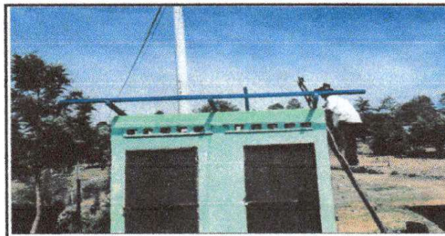
Foto 6: Instalando costanera y lamina troquelada
