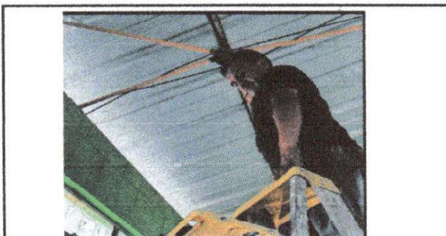
Foto 5: cambio de cableado eléctrico en aula
