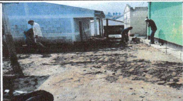
Foto1: Enparejando area de cocina para la fundición para la fundición de piso de torta
