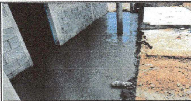
Foto 2: Fundición de piso de torta de cemento
