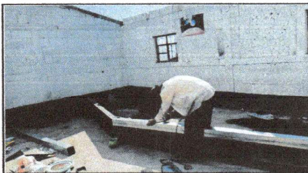
Foto 4: Instalación de costaneras y lamina troquelada aluzinc calibre 26
