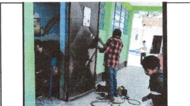
Foto 3: cambio de chapas en aulas
